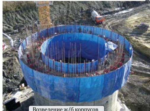
Возведение ж/б корпусов цементных силосов (6шт) и силосов сырьевой муки (2шт) с использованием скользящей опалубки (диаметром от 16 до 45 метров, высотой от 22, до 65 метров)
