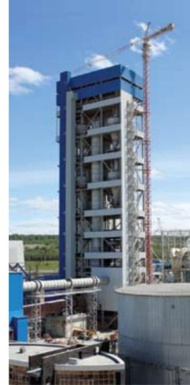
Произведены работы по монтажу металлоконструкций здания «циклонного теплообменника» высотой 125 и 136м, общим весом 3107тн и 3500тн с обшивкой профлистом по всей высоте (монтаж одновременно тремя кранами)
